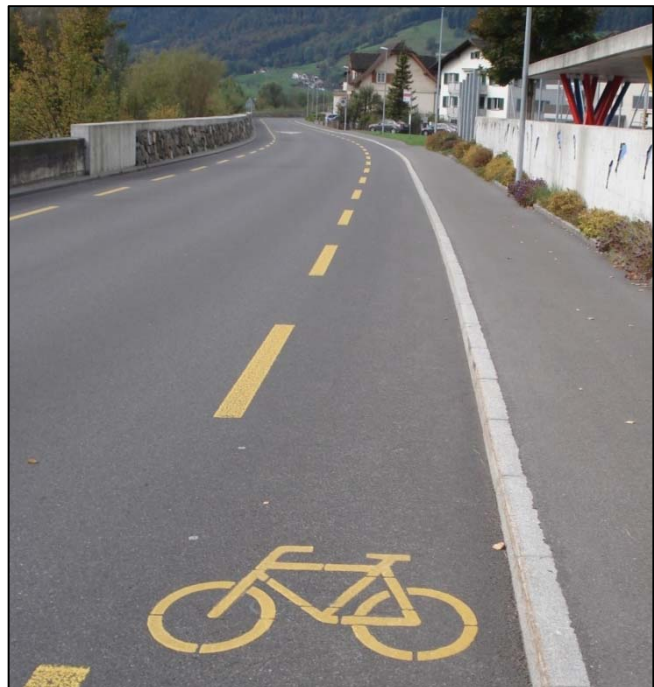
Abb. 15: Kernfahrbahn mit Radstreifen. (TBA 2014)
